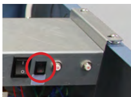
Figura 18 (izquierda): Interruptor de la batería de reserva del control de acceso/sistema de monitoreo (rodeado con un círculo).
