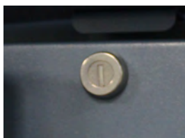
Figura 18 (izquierda): Interruptor de la batería de reserva del control de acceso/sistema de monitoreo (rodeado con un círculo).
