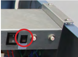
Figura 18 (sinistra): Sistema di monitoraggio/interruttore della batteria di backup di Access Control (cerchiato). Figura 19 (destra): Serratura esterna.
