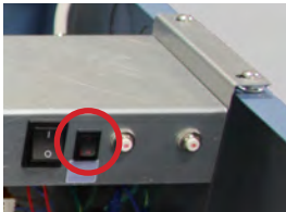
Abbildung 18 (links): Schalter der Reservebatterie für das Überwachungssystem/die Zugangskontrolle (eingekreist). Abbildung 19 (rechts): Außentürschloss.
