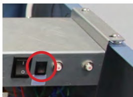
Figure 18 (à gauche) : commutateur de la batterie de secours du système de surveillance/contrôle des accès (entouré) Figure 19 (à droite) : serrure de la porte extérieure
