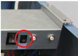
Figur 18 (venstre): Overvågningssystemets/adgangskontrollens backup-batteris afbryder (med cirkel omkring).
