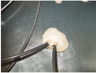
Toegang poort bovenaan - rechtopstaande koelkast
