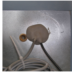
Toegang poort achteraan - ingebouwde koelkast
